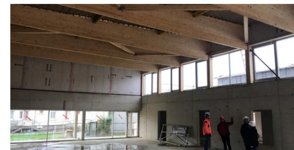
La charpente et la couverture ont été finalisées fin novembre. La salle est maintenant hors d'eau. La pose des briquettes ainsi que le remblai autour de la salle seront réalisés pour le début d'année. La livraison de la salle est toujours prévue pour le début du printemps.
